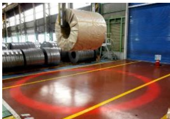
図4. クレーン下の注意喚起照明
